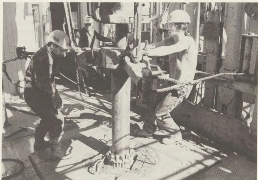
Arbeit auf der Bohr- stelle: Eine neue Verrohrung wird eingebaut.
