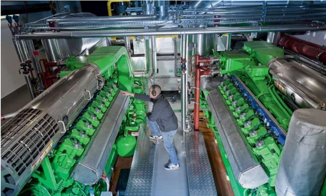
Heizzentrale des Wärmeverbundnetzes: Blockheizkraftwerke, 2011.
