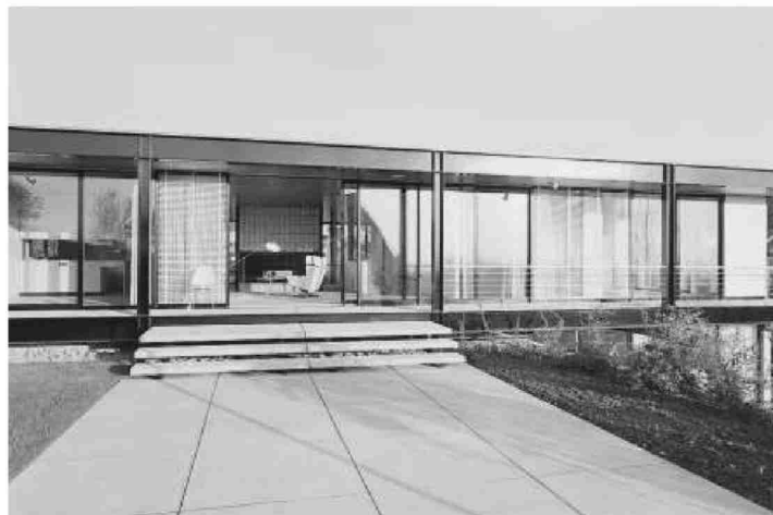
So sah das Haus nach seiner Fertigstellung aus.
