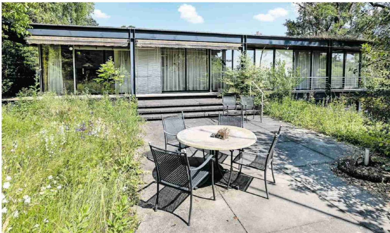
Elegantes Stahlskelett auf einem Betonsockel: das Haus Sponagel in Riehen.
