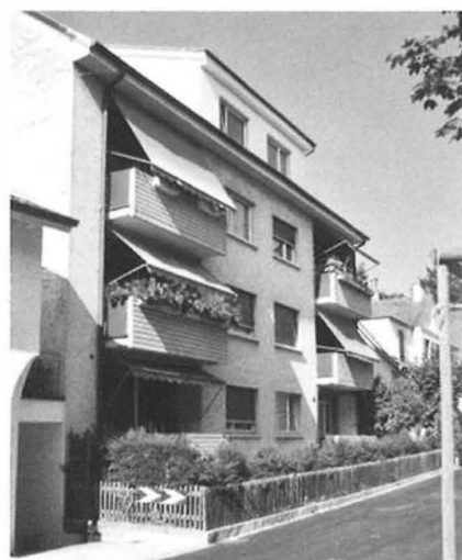
47. Mehrfamilienhaus Gartengasse 9, Aufnahme 2000.
