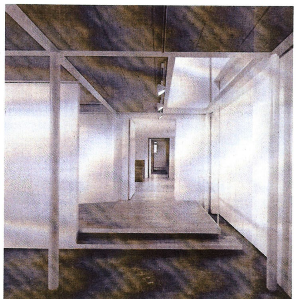
Die Ausstellungshalle im Eingangsbereich. Die Ausstellungsebenen wurden als Stahlbetonkonstruktion in den grossen Ökonomieraum des Tenns eingebaut.
