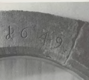
Bogensturz des Kellereingangs mit der Jahreszahl des Baujahres 1649, heute an neuem Ort eingebaut
