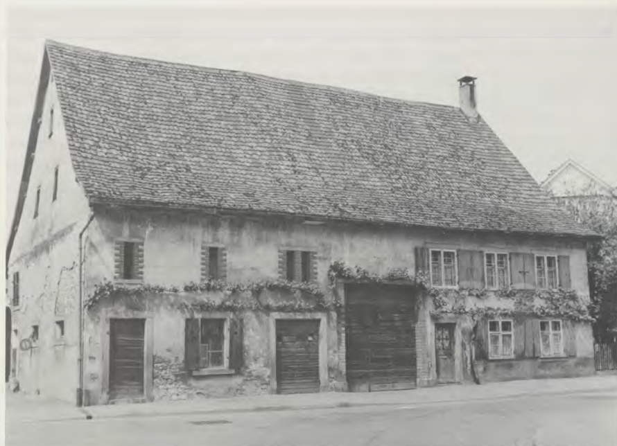
Das 1649 erbaute Bauernhaus Rössli-gasse 19 vor dem Umbau. Stall, Tenn und Wohnteil sind an der Strassenfassade deutlich ablesbar. Aufnahme 1975
