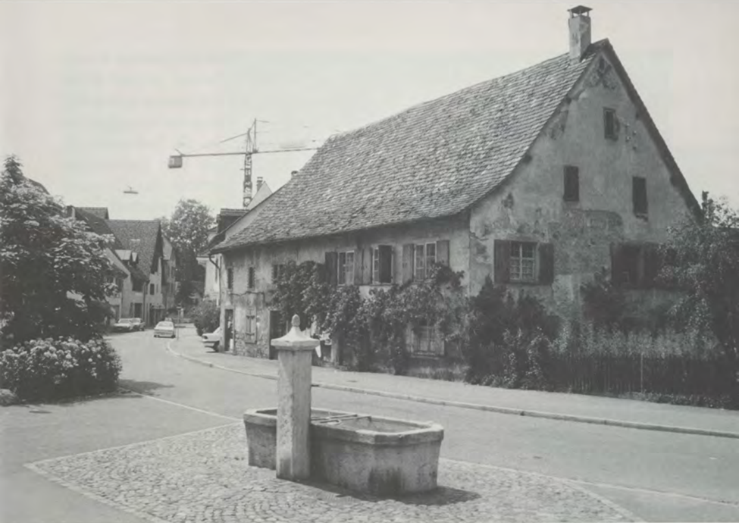
Das 1649 erbaute Bauernhaus Rössligasse 19 kurz vor dem Umbau. Aufnahme 1991
