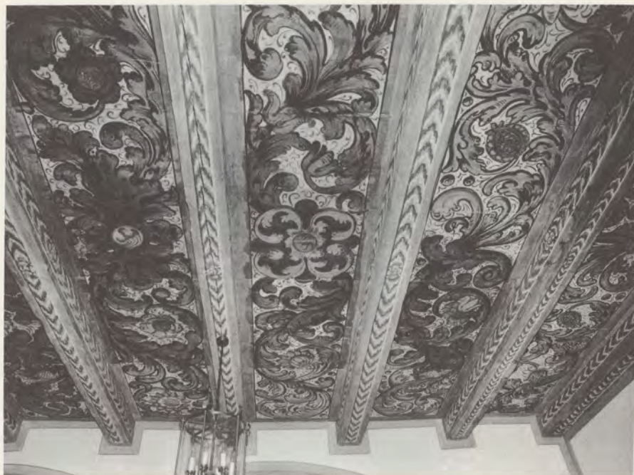
Detail aus der freigelegten bemalten Balkendecke im 1. Stock des Treppenhauses
