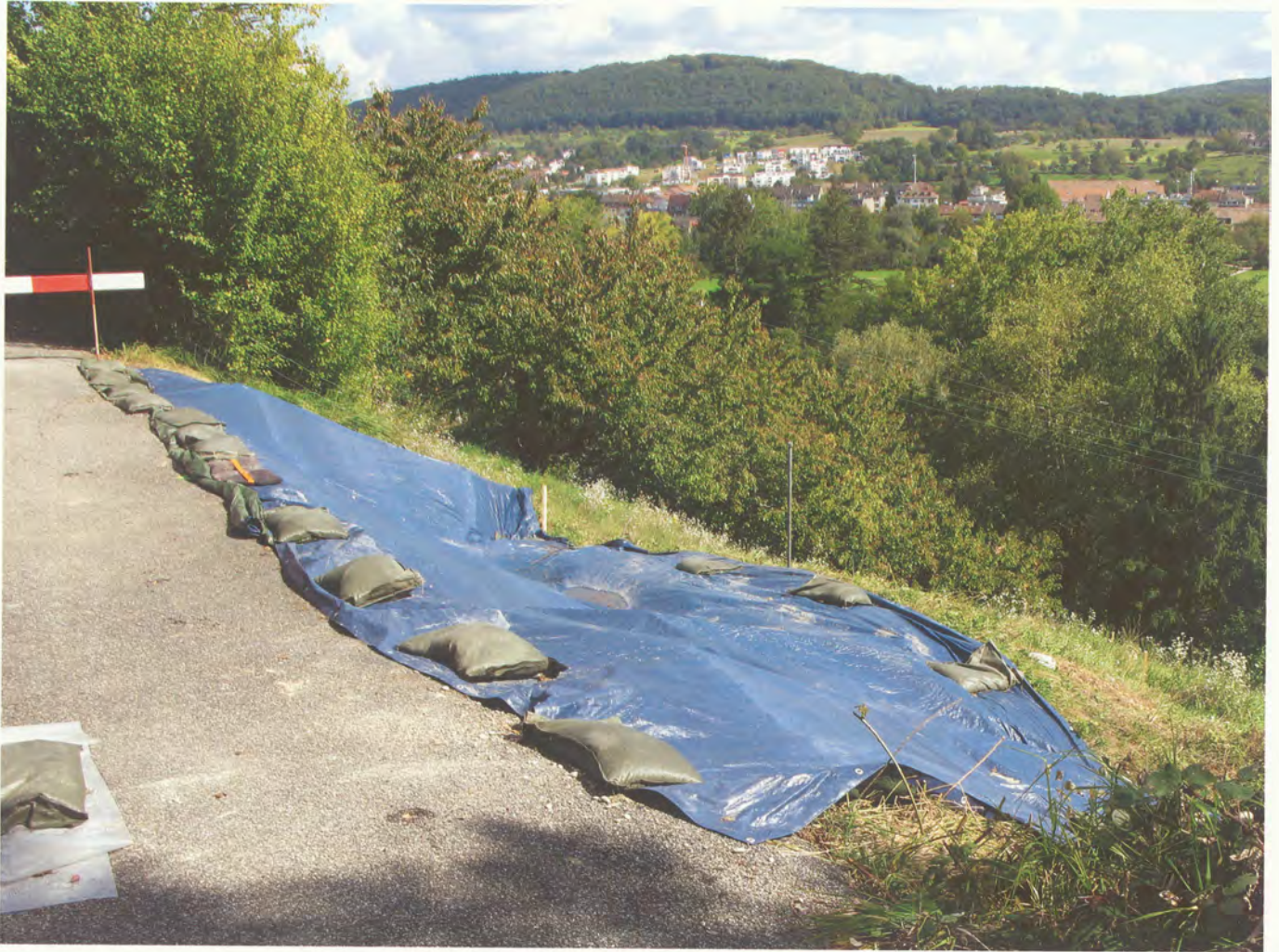
Hangrutsch vom August 2007 am Nägeliweg. Um weiteres Eindringen von Wasser zu verhindern, wurde das Rutschgebiet mit Blachen abgedeckt.
