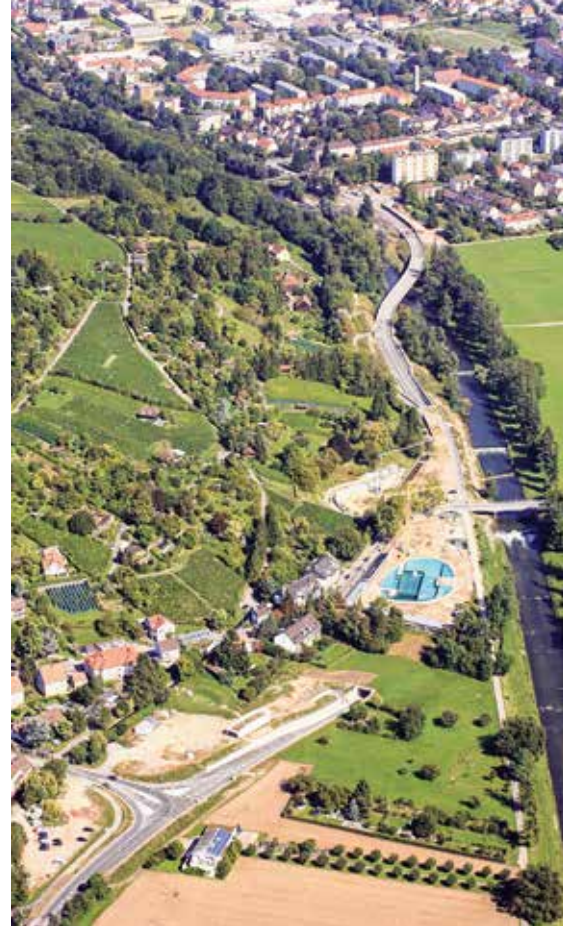
Die Zollfreistrasse mit dem neu eingeweihten Tunnel von oben, im Hintergrund Lörrach.
