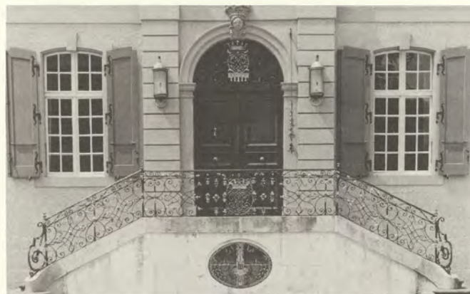
Der Treppenaufgang zum Neuen Wenken
