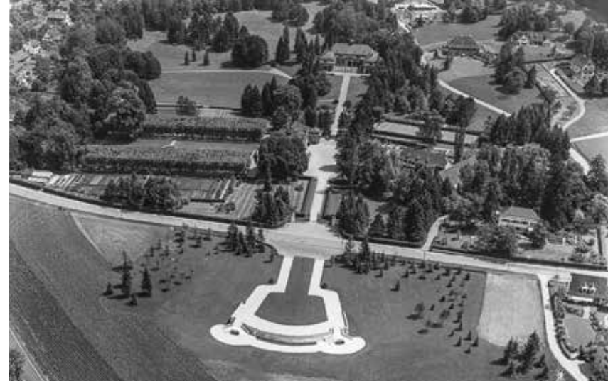
Die Luftaufnahme von 1975 zeigt die von Alexander Clavel neu angelegte Hauptachse zwischen der Reithalle (1925) im Hintergrund und der Terrasse vorne (1957). Auf seinen Wunsch war die Bettingerstrasse Ende der 1930er-Jahre begradigt worden. So konnte er die Hauptachse um 60 Meter verlängern und eine grosszügige Zufahrt zum Ehrenhof gestalten.
