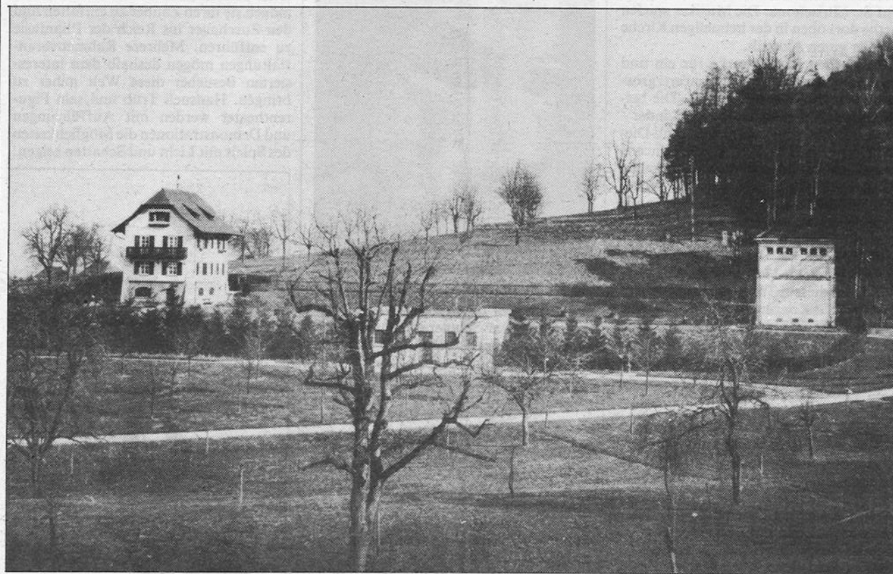
Wenn die Riehener Wasserversorgung in diesem Jahr auf ihr hundertjähriges Bestehen zurückblicken kann, so ist das Bild der ersten Bauten der Basler Wasserversorgung in Riehen, des Reservoirs Wenkenhof von 1922, mit Fotodatum 1934, auch schon über ein halbes Jahrhundert alt. Alles sah damals noch recht kahl aus.
