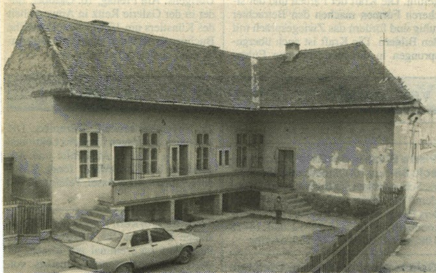
Das Dach des Haupttraktes des Sozialhauses konnte mittlerweile saniert werden.
