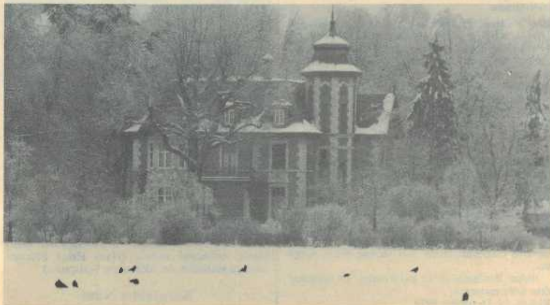
Bäumlhof: Grossratskommission ist gegen eine teilweise Überbauung.
