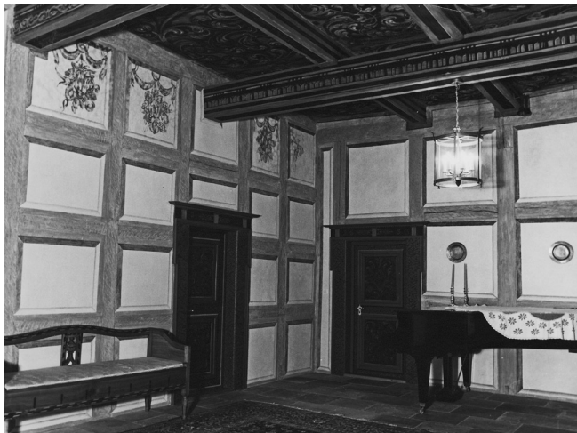
131. Die obere Halle mit reich bemalter Balkendecke, die verputzten Zwischenfelder der Riegelwand farbig eingefasst, das Holzwerk bemalt (1977).
