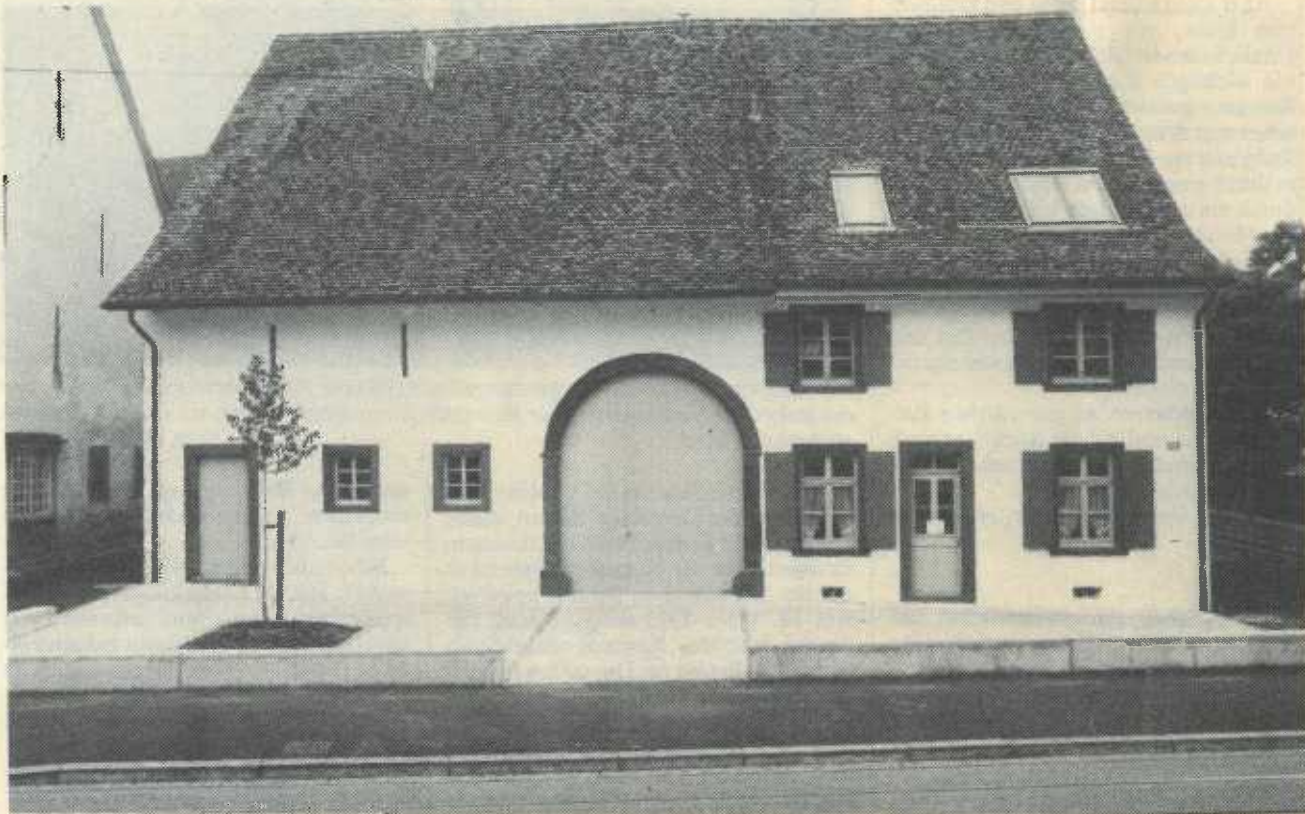
Das renovierte Haus «Zur Waage», Seite Baselstrasse. Im alten Scheunenteil (links) wurde die Bibliothek eingerichtet.
