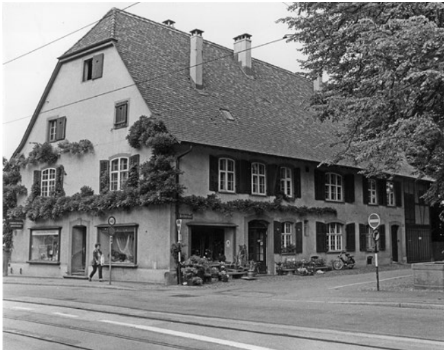
55. Das 1982 umgebaute Wohn- und Geschäftshaus Kirchstrasse 1 / Baselstrasse 31 (1982).
