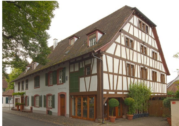
56. Die 1982 restaurierte Giebelfassade mit Ständer- und Riegelkonstruktion, die vermutlich auf das 16. Jahrhundert zurückgeht (2017).
