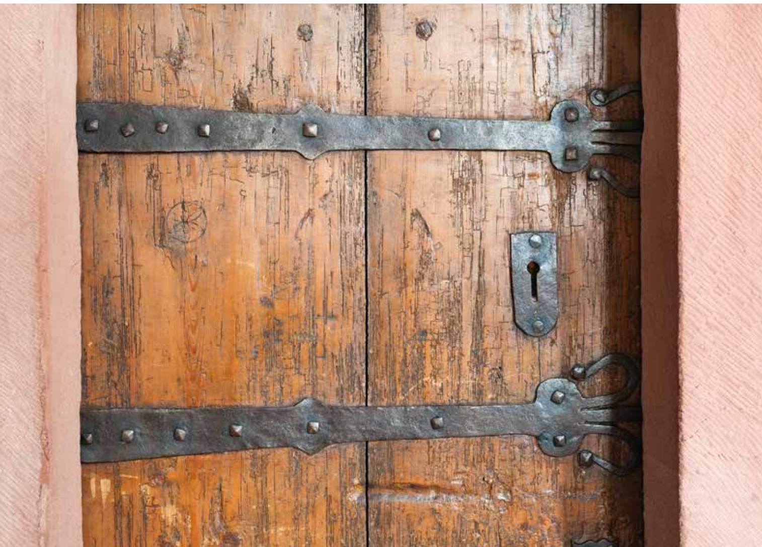
Die Tür zur Sakristei besteht aus zwei Brettern aus Nadelholz und stammt aus dem 15. oder frühen 16. Jahrhundert. Sie wurde von einem Zimmermann mit der Axt grob geschlichtet und verfügt noch über die originalen Eisenbeschläge, das Werk eines Schmieds.
