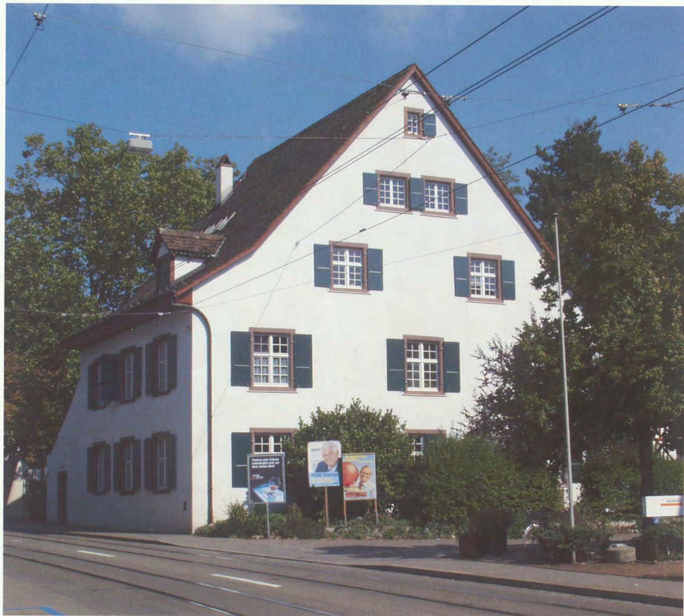
Das Fischerhus an der Baselstrasse 24
