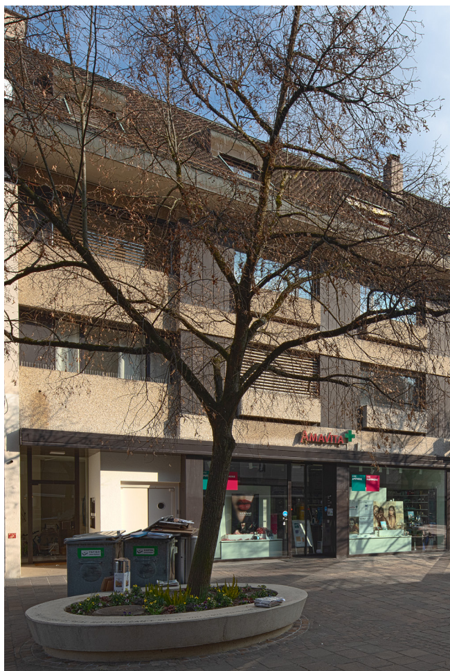
212. Die Überbauung Webergässchen 6 von 1974/75 (2022), Ausschnitt aus Abb. 209.
