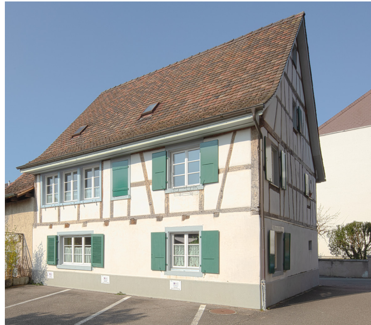
200. Spitalweg 10–12, Rückfassade nach der Renovierung von 1993 (2022).
