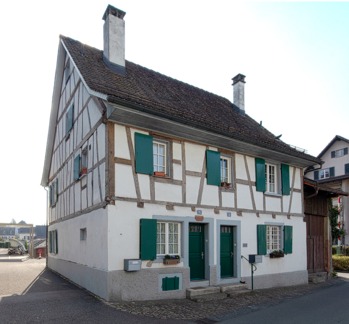
199. Spitalweg 10–12, Strassenfassade nach der Restauration von 1993 (2022).
