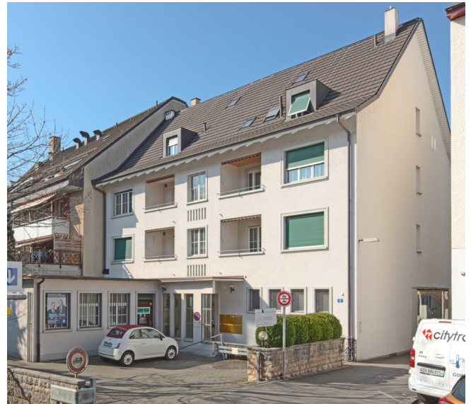
182. Schopfgässchen 2, Rückseite des Gebäudes mit ein- geschossigem Anbau (2022).
