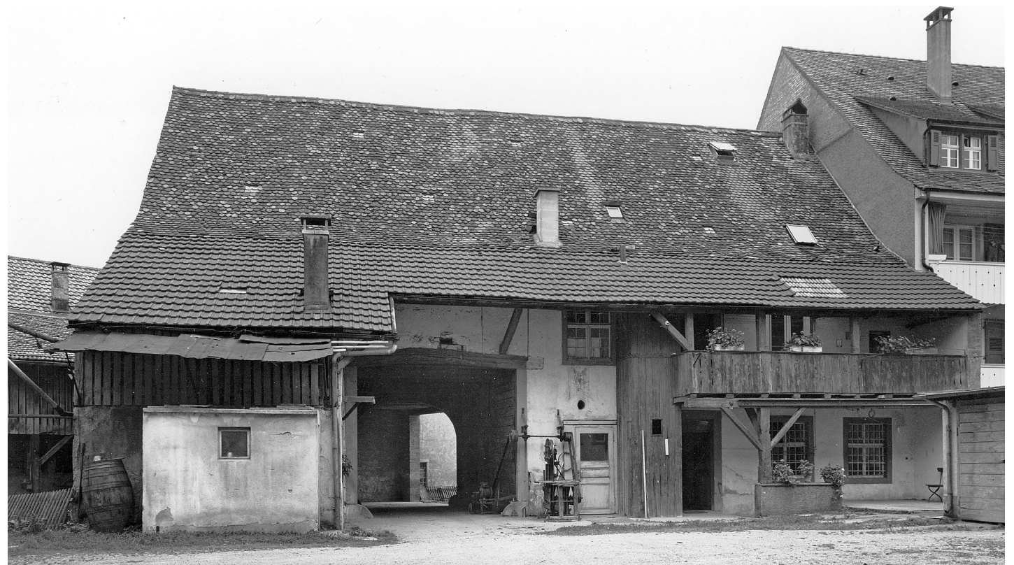
145. Rückseite des Hauses Baselstrasse 26 (1964). Links neben dem Scheunentor Stallbauten, rechts der Wohnbereich mit Laube.
