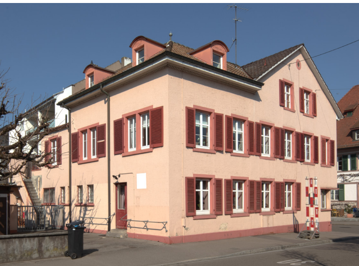
94. Schmiedgasse 40, Rückseite und Fassade zur Bahnhofstrasse (2022).
