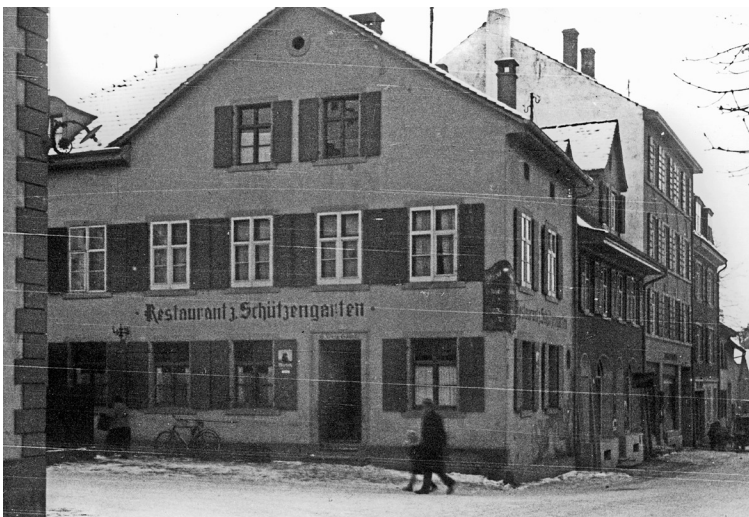
92. Schmiedgasse 40, Eckansicht Bahnhofstrasse/Schmiedgasse vor dem Umbau (1932).
