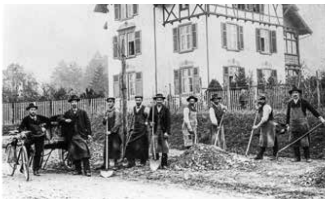
Strassenbauarbeiten an der Aeusseren Baselstrasse um 1910.
