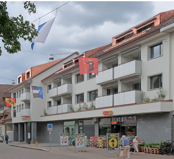
24. Wohn- und Geschäftshaus Schmiedgasse 7–9 nach dem Umbau von 2022.
