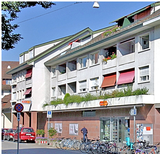
25. Die Fassade gegen die Schmiedgasse vor dem Umbau von 2022.
