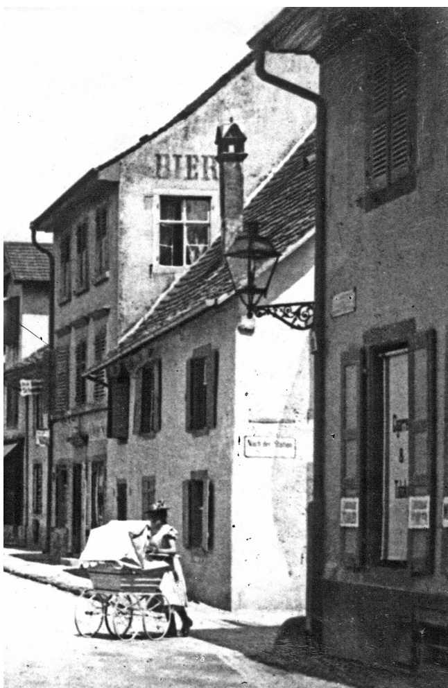
13. Traufseite des Hauses Schmiedgasse 1 (in der Bildmitte) vor dem Abbruch 1928.
