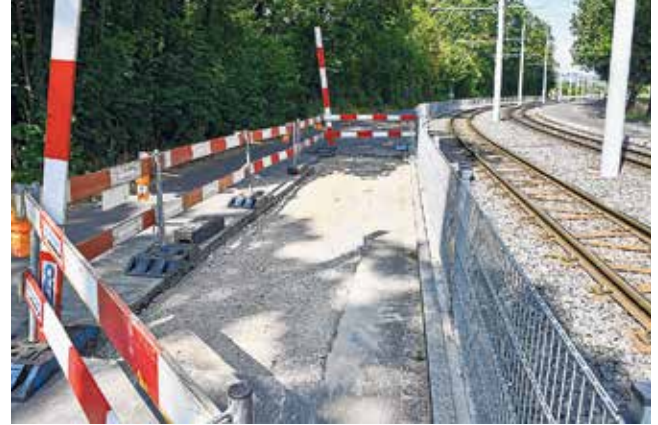
Baustelle nach Behebung des Leitungsschadens an einem IWB-Stromkabel Ende Juni 2023 an der Riehenstrasse nahe der Tramschleife Eglisee.
