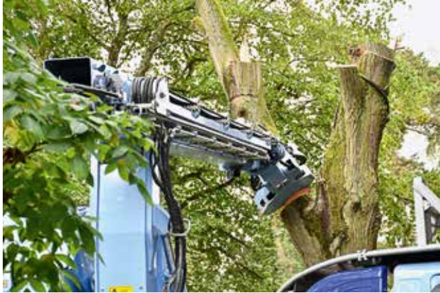
Fällarbeiten an einer grossen Silberlinde am 31. August 2023 auf der Wettsteinanlage.
