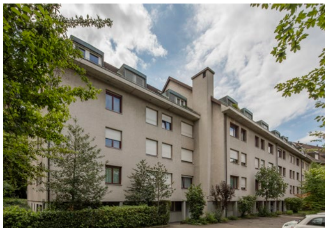
112. Mehrfamilienhaus Baselstrasse 22a/b/c (2017).
