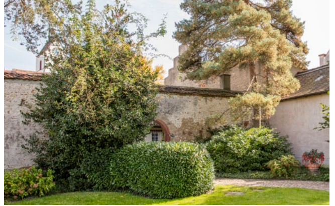
62. Zugangsbereich der Liegenschaft Baselstrasse 11 (2017). Im Hintergrund der erhaltene Stufengiebel der ehemaligen Zehntenscheune.
