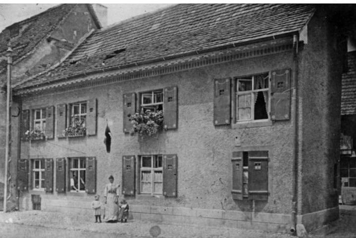
35. Das Bauernhaus Baselstrasse 19 um 1910. Links angebaut das Haus Baselstrasse 17.
